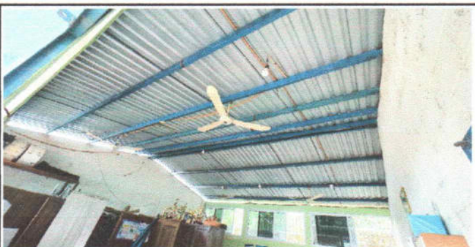
Reparación de cableado eléctrico CALIBRE 12 AWG
