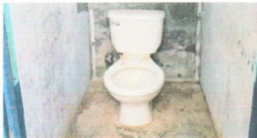
Sustitución inodoro elongado
