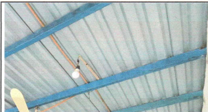
Sustitución de lámparas existentes con lámparas BOMBILLO LED GLOBO 30W PARA PASILLOS 2400 lúmenes
