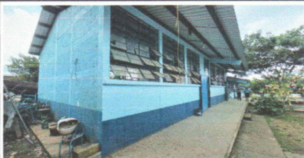
Suministro y aplicación Pintura exterior látex celeste Pantone 293 para muros
