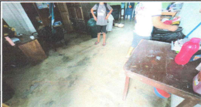
Sustitución de piso de granito y torta de concreto por piso cerámico
