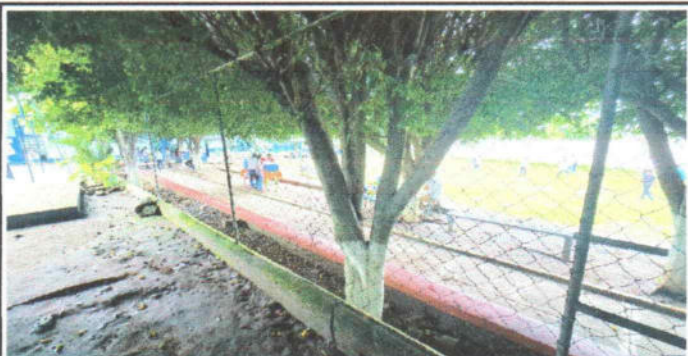
Reparación de tubo hg y malla galvanizada
