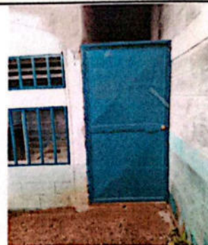
Foto No. 4 Sustitución de puerta metálica
