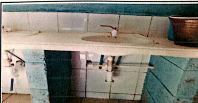
Foto No. 6 Mantenimiento de lavamanos con grifería
