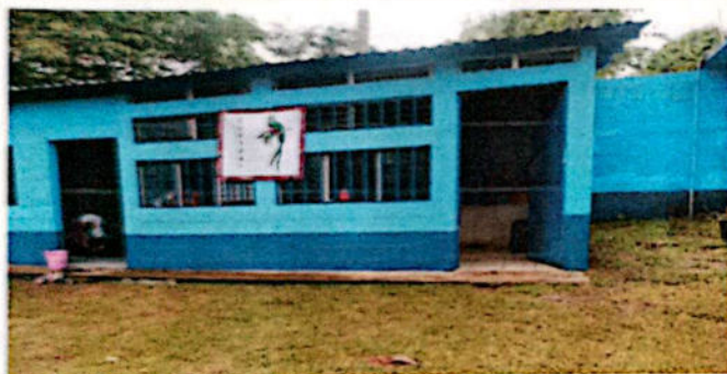
Foto No. 3 Sustitución de balcones
