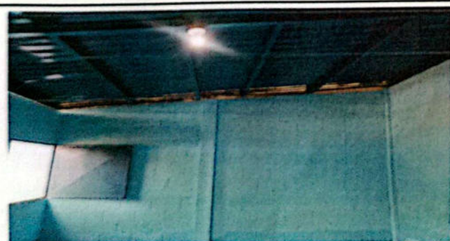
Foto No. 5 Sustitución de lámina, por lámina troquelada Calibre 26
