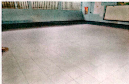
Foto No. 1 Sustitución de piso de torta de concreto por piso cerámico
