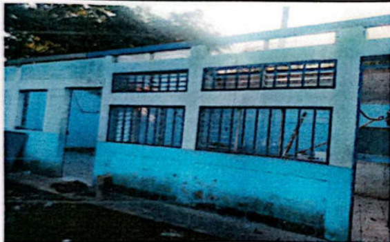
Foto No. 3 Sustitución de balcones
