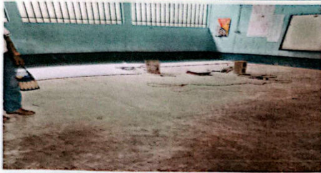
Foto No. 1 Sustitución de piso de torta de concreto por piso cerámico
