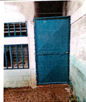
Foto No. 4 Sustitución de puerta metálica
