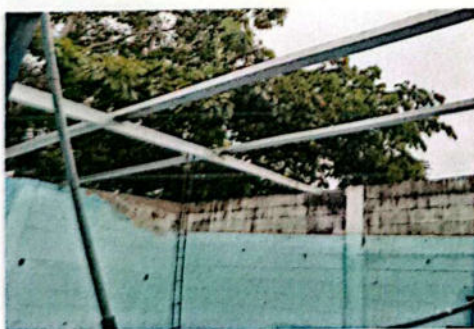
Foto No. 5 Sustitución de lámina, por lámina troquelada Calibre 26
