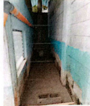
Foto No. 2 Sustitución de piso de torta de concreto de acceso
