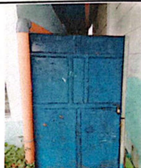
Foto No. 4 Sustitución de puerta metálica
