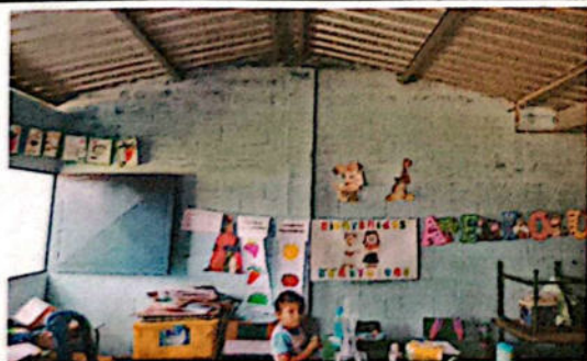
Foto No. 5 Sustitución de lámina, por lámina troquelada Calibre 26
