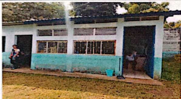
Foto No. 3 Sustitución de balcones
