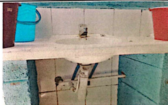
Foto No. 6 Mantenimiento de lavamanos con grifería
