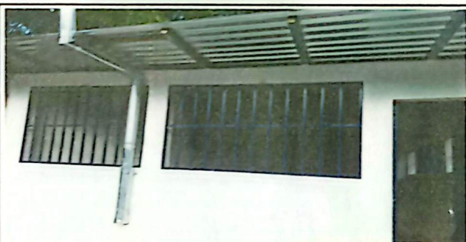
No.10 SUSTITUCION DE LAMINA DE ZINC POR LAMINA TROQUELADA CAL. 26
