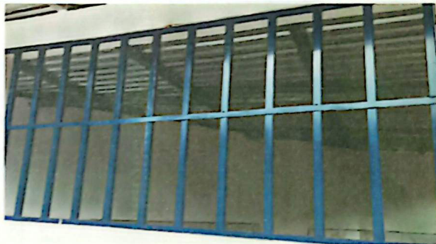
No.8 SUSTITUCIÓN DE BALCONES DE METAL DE TUBO CUADRADO DE 1"
