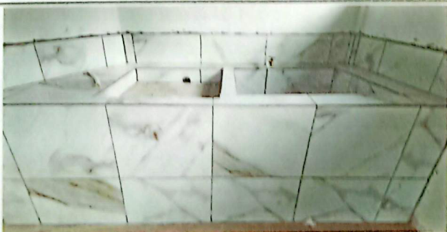
No.5 SUSTITUCION DE PILA DE CONCRETO DE UN ALA
