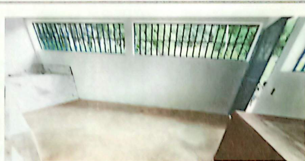
No.4 REPARACION DE REPELLO Y CERNIDO EN MUROS
