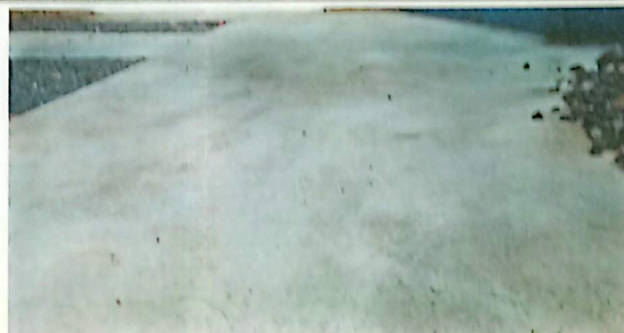
No.2 SUSTITUCIÓN DE PISO DE CONCRETO EN PATIO ESPESOR 0.08M
