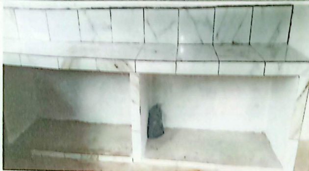
No.1 Sustitución de mesa de trabajo en cocina
