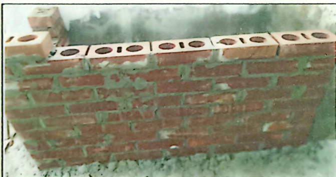
No.3 SUSTITUCIÓN DE ESTUFA DE COCINA CON LADRILLO, PLANCHA DE METAL Y CHIMENEA METALICA
