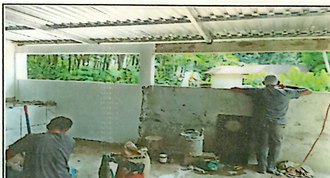
No.4 REPARACION DE REPELLO Y CERNIDO EN MUROS
