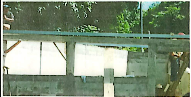
No.10 SUSTITUCION DE LAMINA DE ZINC POR LAMINA TROQUELADA CAL. 26
