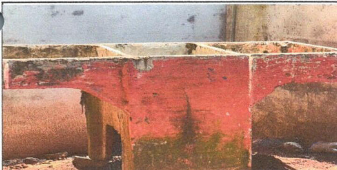
No.5 SUSTITUCION DE PILA DE CONCRETO DE UN ALA
