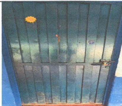
No.7 SUSTITUCION DE PUERTA DE METAL
