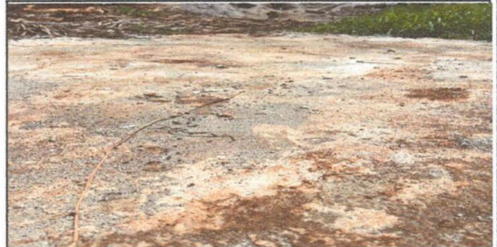
No.2 SUSTITUCIÓN DE PISO DE CONCRETO EN PATIO ESPESOR 0.08M
