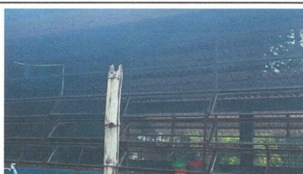
No.8 SUSTITUCIÓN DE BALCONES DE METAL DE TUBO CUADRADO DE 1"
