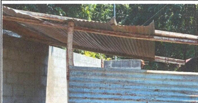
No.9 SUSTITUCIÓN DE ESTRUCTURA DE SOPORTE DE METAL POR METAL
