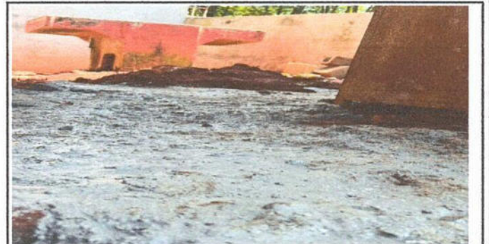
No.6 SUSTITUCIÓN DE PISO DE TORTA DE CONCRETO ESPESOR 0.10M
