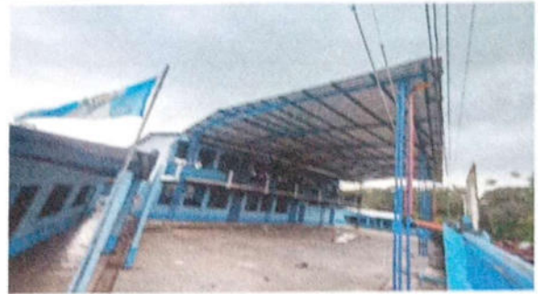
Foto 2: Sustitución de poste de madera por estructura metálica
