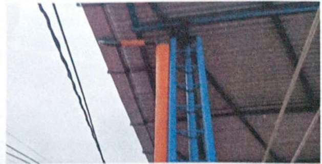
Foto 4: Sustitución de bajada de agua pluvial con tubería PVC 4"
