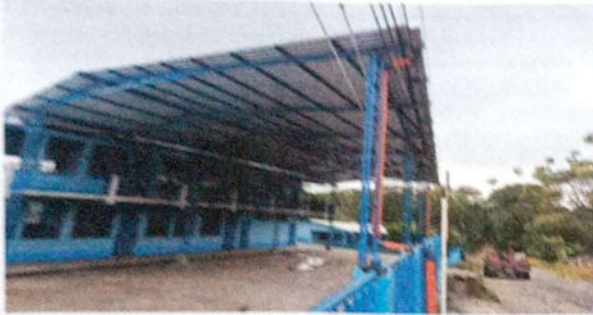
Foto 1: Sustitución de Lona por lamina troquelada calibre 26
