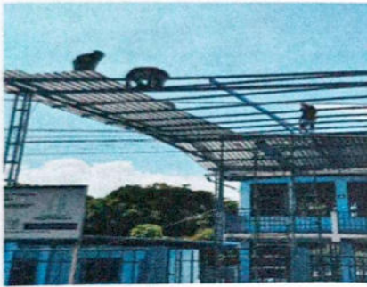
Foto 1: Sustitucion de Lona por lamina troquelada calibre 26
