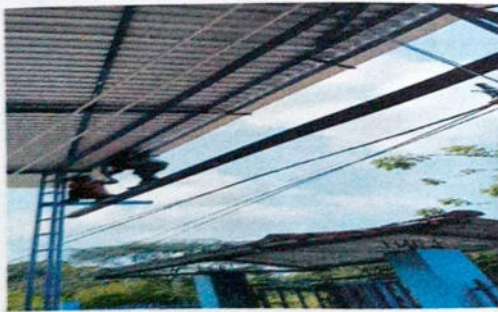
Foto 3: Sustitucion de canales de lluvia PVC de 4" en Cubierta
