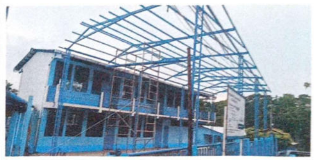
Foto 2: Sustitucion de poste de madera por estructura metalica
