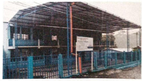
Foto 4: Sustitucion de bajada de agua pluvial con tuberia PVC 4"
