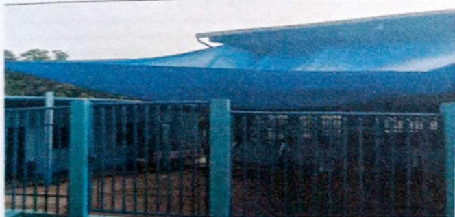
No.3 Sustitución de canales de lluvia PVC de 4" en cubierta
