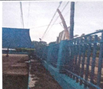
No.2 Sustitución de postes de madera por estructura metálica
