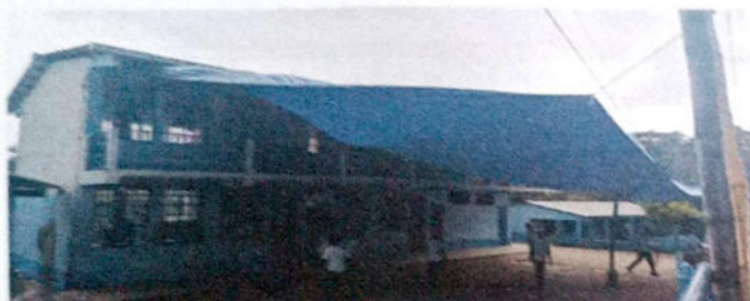
No.1 Sustitución de Lona por lamina troquelada calibre 26
