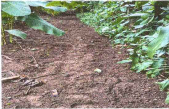
FOTO 1: Sustitución de tubería pvc con diametro de 24", 25 metros lineales
