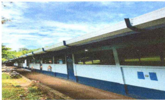
FOTO 3: Sustitución de canal metálico de alto caudal en cubierta, 108 metros lineales
