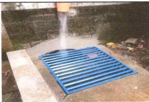
FOTO 5: Sustitución de caja de unión con rejilla
