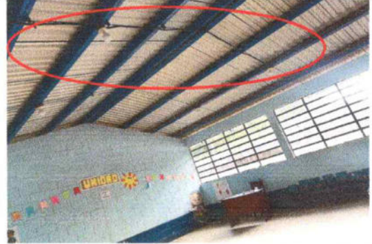
FOTO 2: Sustitución de 35 luminarias LED de 30W
