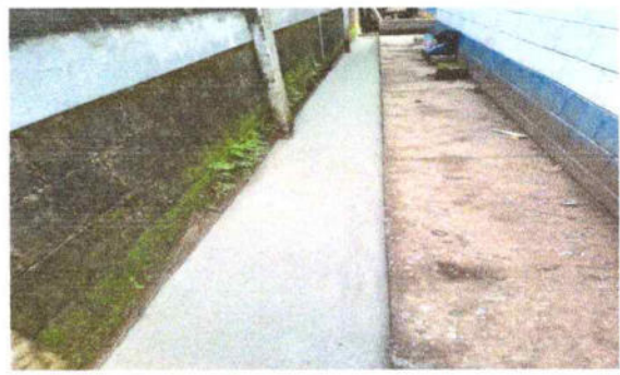
FOTO 4: Sustitución de tubería pvc 4" para drenaje pluvial, 160 metros lineales
