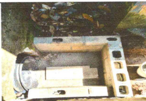
FOTO 5: Sustitución de caja de unión con rejilla
