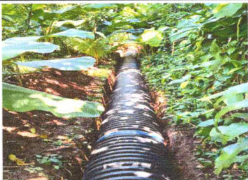
FOTO 1: Sustitución de tubería pvc con diametro de 24", 25 metros lineales
