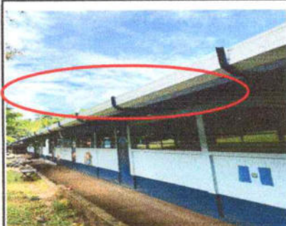
FOTO 3: Sustitución de canal metálico de alto caudal en cubierta, 108 metros lineales
