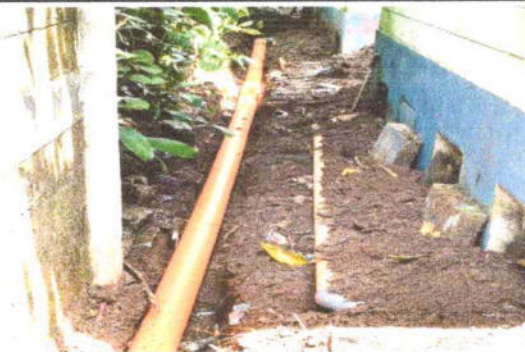
FOTO 4: Sustitución de tubería pvc 4" para drenaje pluvial, 160 metros lineales
