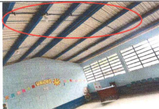
FOTO 2: Sustitución de 35 luminarias LED de 30W
