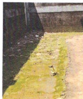
Sustitución de tubería pvc 4" para drenaje pluvial
