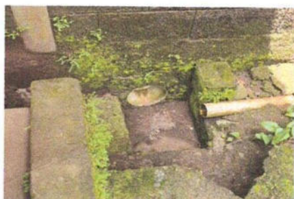
Sustitución de caja de unión con rejilla
