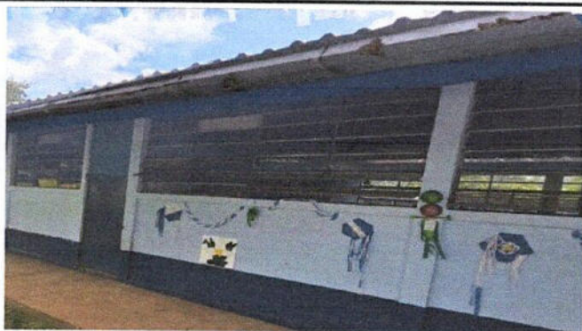
Sustitución de canal metálico de alto caudal en cubierta
