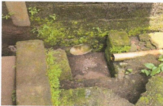
Sustitución de tubería pvc con diametro de 24"
