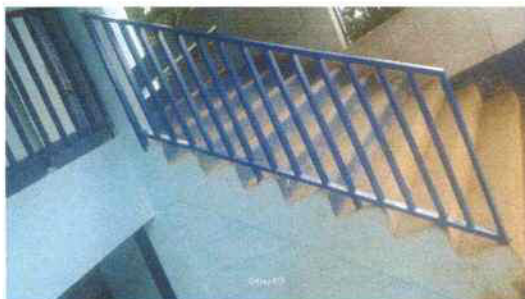
Foto 9: MANTENIMIENTO CORRECTIVO DE BARANDAS METÁLICAS
