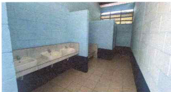
Foto 5: MANTENIMIENTO PREVENTIVO DE PINTURA EN MUROS INTERIORES DE SERVICIOS SANITARIOS
