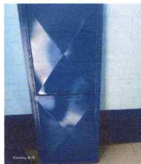
Foto 10: SUSTITUCIÓN DE PUERTA DE SERVICIOS SANITARIOS METÁLICA
