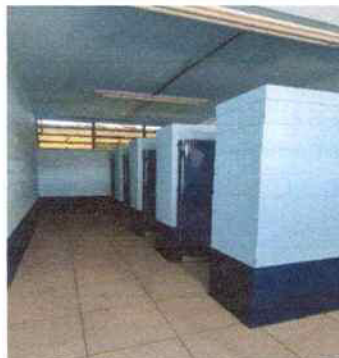
Foto 2: SUSTITUCIÓN DE PISO DE CEMENTO LIQUIDO A PISO CERAMICO
