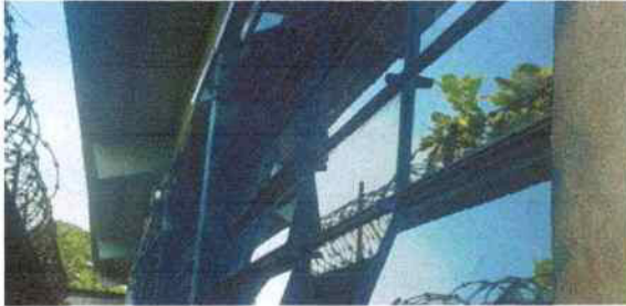
Foto13: SUSTITUCIÓN DE VIDRIO DE 5MM
