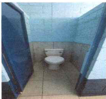
Foto 3: SUSTITUCIÓN DE INODORO ENLOGADO
