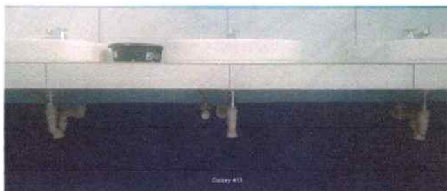
Foto7: SUSTITUCIÓN DE TUBERÍA PVC LÍNEA PRINCIPAL DE AGUA DE 1/2"
