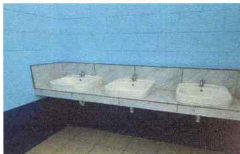
Foto 4: SUSTITUCIÓN DE LAVAMANOS CONGRIFERÍA
