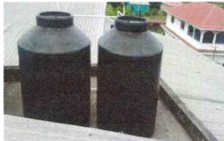
Foto 8: SUSTITUCIÓN DE ACCESORIOS DEPÓSITO DE AGUA
