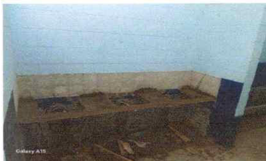
Foto 4: SUSTITUCIÓN DE LAVAMANOS CONGRIFERÍA
