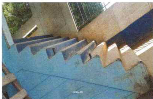
Foto 9: MANTENIMIENTO CORRECTIVO DE BARANDAS METÁLICAS
