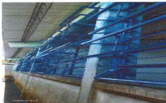
Foto 12: MANTENIMIENTO CORRECTIVO DE ESTRUCTURA DE METÁLICA EN VENTANAS
