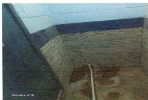
Foto 6: SUSTITUCIÓN DE TUBERIA PVC LINEA PRINCIPAL AGUAS NEGRAS
