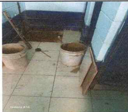
Foto 2: SUSTITUCIÓN DE PISO DE CEMENTO LIQUIDO A PISO CERAMICO
