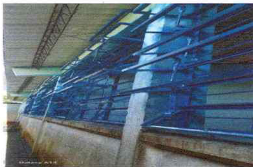
Foto13: SUSTITUCIÓN DE VIDRIO DE 5MM
