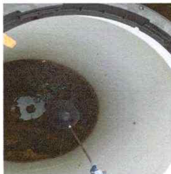
Foto 8: SUSTITUCIÓN DE ACCESORIOS DEPÓSITO DE AGUA
