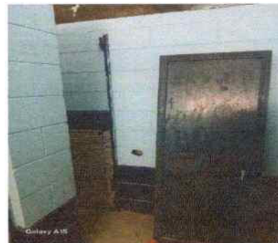
Foto 10: SUSTITUCIÓN DE PUERTA DE SERVICIOS SANITARIOS METÁLICA
