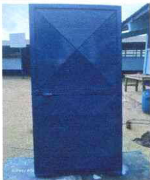
Foto 11: MANTENIMIENTO CORRECTIVO DE PUERTAS METÁLICAS
