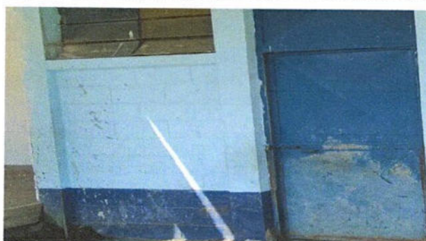
MANTENIMIENTO CORRECTIVO DE ESTRUCTURA DE METÁLICA EN VENTANAS
