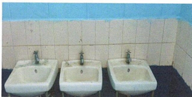
SUSTITUCIÓN DE AZULEJO
