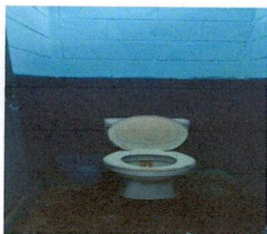
SUSTITUCIÓN DE INODORO ELONGADO
