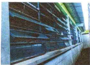
SUSTITUCION DE VIDRIO DE 5MM
