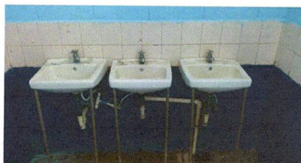
SUSTITUCIÓN DE LAVAMANOS CON GRIFERIA
