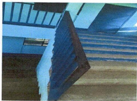
MANTENIMIENTO CORRECTIVO DE BARANDAS METÁLICAS
