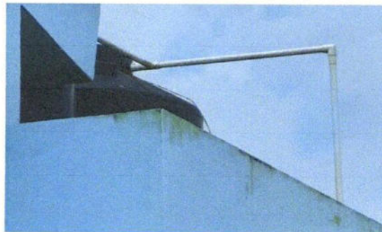
SUSTITUCION DE ACCESORIOS DEPOSITO DE AGUA
