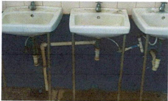
SUSTITUCION DE TUBERIA PVC LINEA PRINCIPAL DE AGUA DE 1/2"
