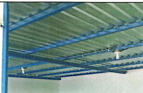
FOTO 9: SUSTITUCION DE ESTRUCTURA DE SOPORTE DE METAL POR METAL
