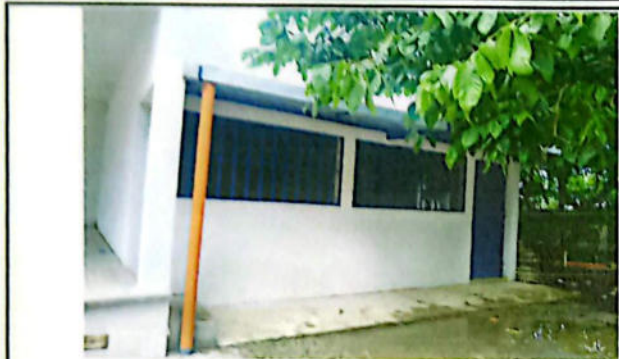
FOTO 1: REPARACION DE MURO CON COLUMNAS DE 0.15X0.15X2.50
