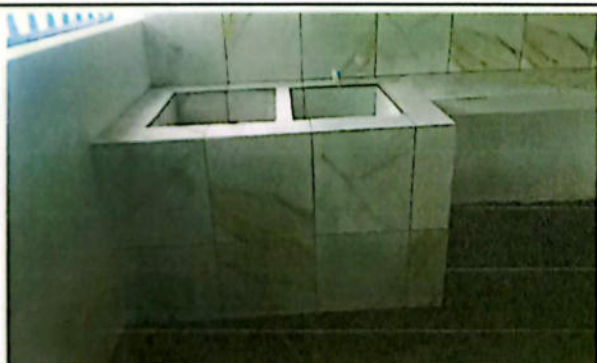
FOTO 5: SUSTITUCIÓN DE PILA POR PILA DE CONCRETO DE UNA ALA EN COCINA
