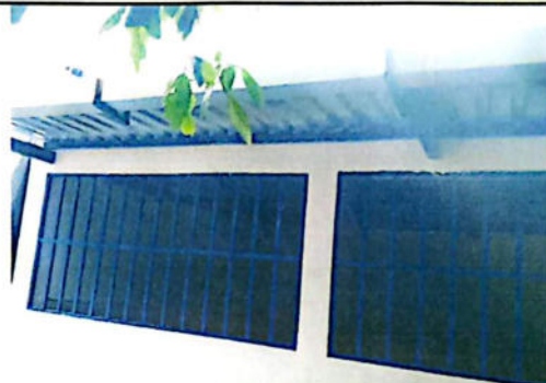
FOTO 8: SUSTITUCION DE BALCONES METALICOS
