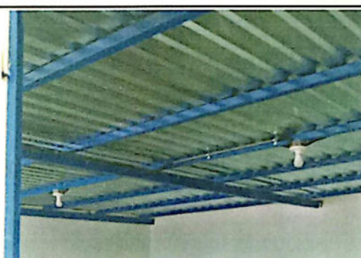
FOTO 10: SUSTITUCION DE LAMINA, POR LAMINA TROQUELADA CAL 26
