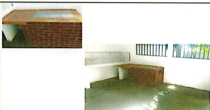
FOTO 3: SUSTITUCIÓN DE ESTUFA DE COCINA CON LADRILLO, PLANCHA DE METAL Y CHIMENEA METALICA
