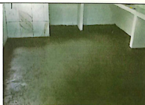
FOTO 6: SUSTITUCIÓN DE PISO DE TORTA DE CONCRETO EN COCINA
