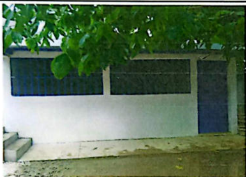
FOTO 7: SUSTITUCION DE PUERTA METALICA
