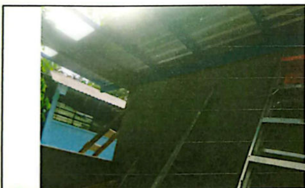
FOTO 11: SUSTITUCION DE LAMINA, POR LAMINA TROQUELADA CAL.26
