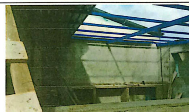
FOTO 10: SUSTITUCION DE ESTRUCTURA DE SOPORTE DE METAL POR METAL
