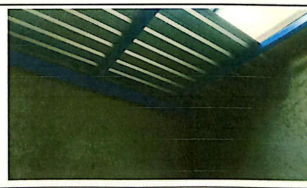
FOTO 12: SUSTITUCION DE LAMINA, POR LAMINA TROQUELADA CAL.26
