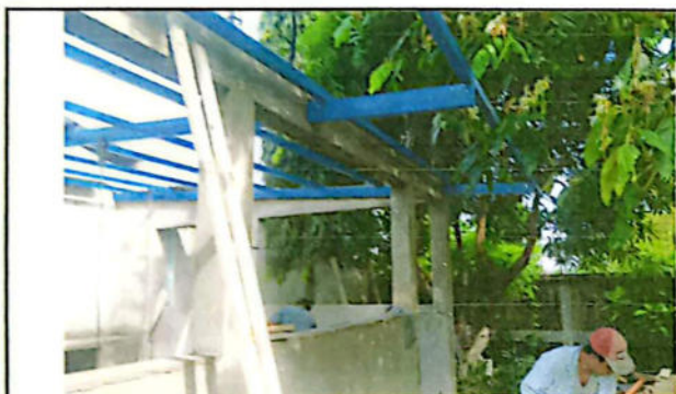
FOTO 9: SUSTITUCION DE ESTRUCTURA DE SOPORTE DE METAL POR METAL
