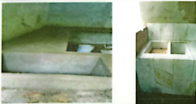
FOTO 5: SUSTITUCIÓN DE PISO DE PILA DE CONCRETO DE UN ALA
