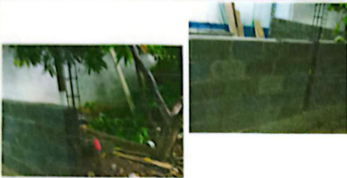
FOTO 1: REPARACION DE MURO CON COLUMNAS DE 0.15X0.15X2.50
