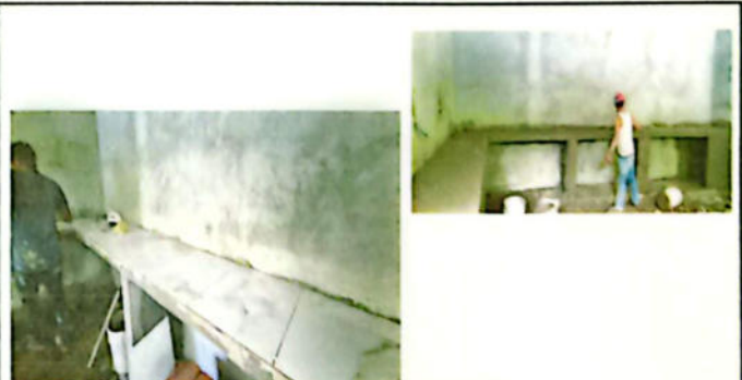
FOTO 4: SUSTITUCIÓN DE MESA DE TRABAJO EN COCINA
