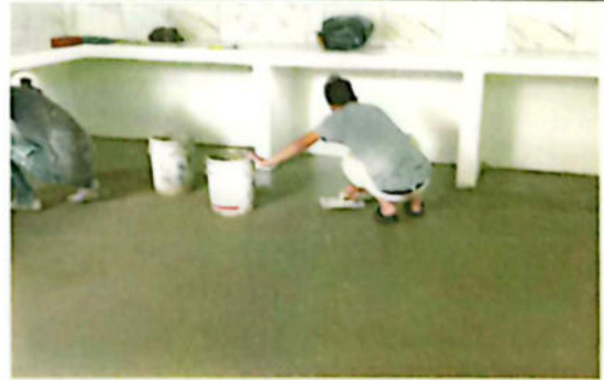
FOTO 6: SUSTITUCIÓN DE PISO DE TORTA DE CONCRETO
