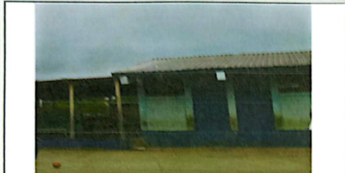
FOTO 7: SUSTITUCION DE PUERTA METALICA
