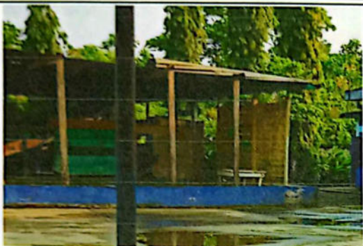
FOTO 1: REPARACION DE MURO CON COLUMNAS DE 0.15X0.15X2.50
