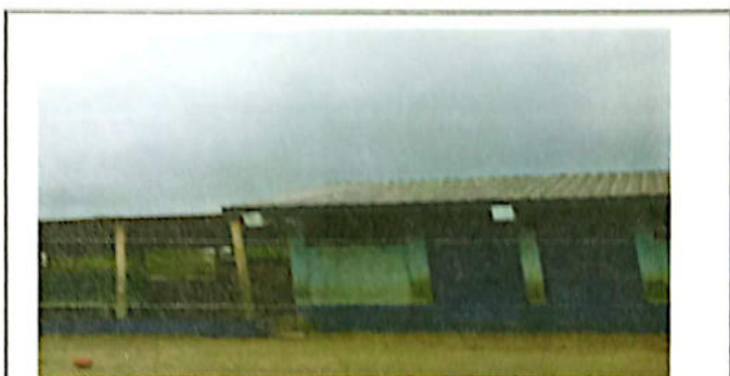
FOTO 10: SUSTITUCION DE LAMINA, POR LAMINA TROQUELADA CAL.28
