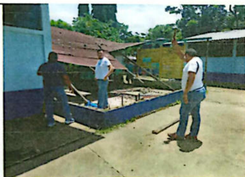
FOTO 3: SUSTITUCIÓN DE ESTUFA DE COCINA CON LADRILLO, PLANCHA DE METAL Y CHIMENEA METALICA
