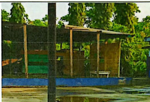
FOTO 2: REPARACION DE MURO CON BLOCK DE 50 Kg/cm2 DE 14X19X39
