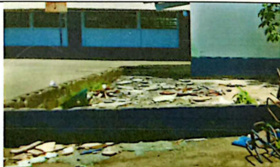
FOTO 6: SUSTITUCIÓN DE PISO DE TORTA DE CONCRETO POR CONCRETO
