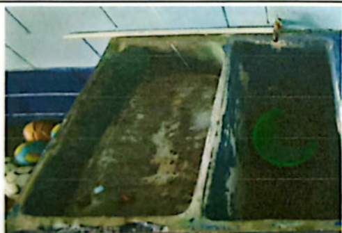
FOTO 5: SUSTITUCIÓN DE PILA DE CONCRETO DE UN ALA
