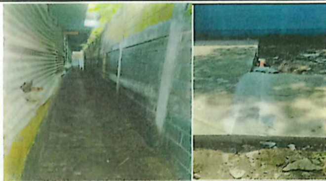
FOTO # 2. Sustitución de tubería PVC línea principal aguas negras 4"
