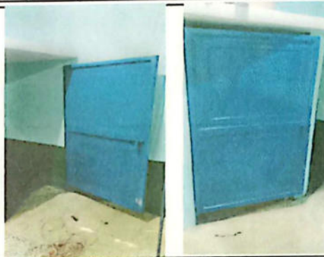
No.8 Sustitución de puerta de servicios sanitarios metálica
