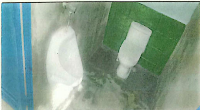
FOTO # 4. Sustitución de mingitorio S/ Loza BL D02 color blanco para preprimaria
