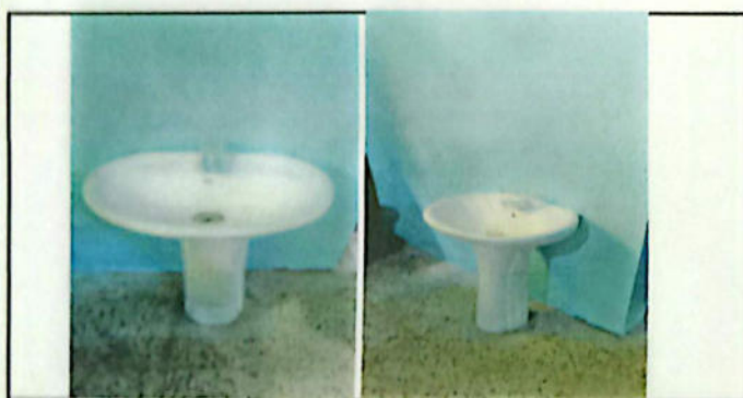
FOTO # 5. Sustitución lavamanos con grifería marca Prepon LL C/pedestal. S/loza color blanco para preprimaria
