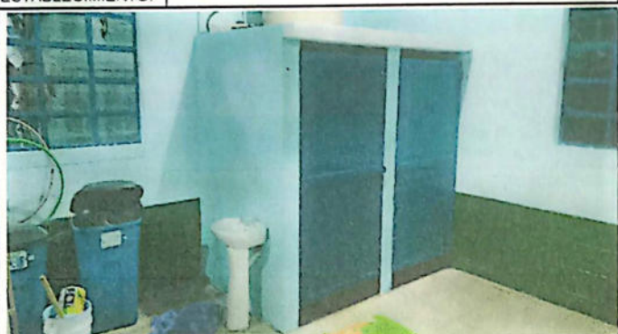
No.7 Reparación de Muro con Block 50 Kg/cm2 14x19x39cm
