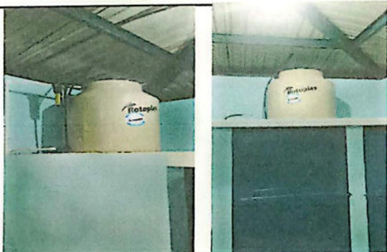
No.9 Sustitución de depósitos de agua 450 lts
