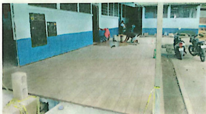
FOTO # 6. Sustitución de piso cerámico
