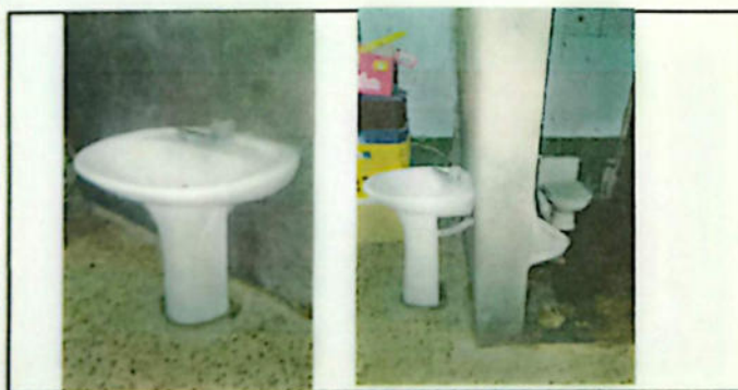
No.5 Sustitución lavamanos con grifería marca Prepon LL C/pedestal. S/loza color blanco para preprimaria
