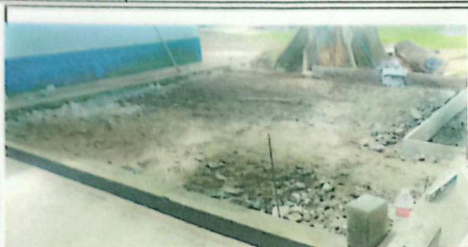
No.1 Reparación de plancha de concreto de patio.
