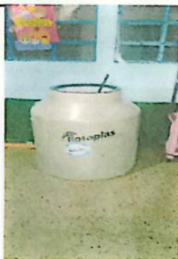
No.9 Sustitución de depósitos de agua 450 lts
