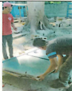
No.8 Sustitución de puerta de servicios sanitarios metálica
