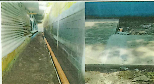
No.2 Sustitución de tubería PVC línea principal aguas negras 4"
