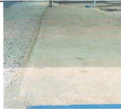
No.6 Sustitución de piso cerámico en Asfalto
