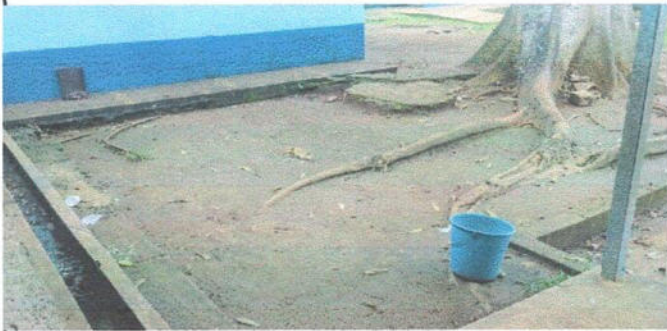
No.1 Reparación de plancha de concreto de patio.
