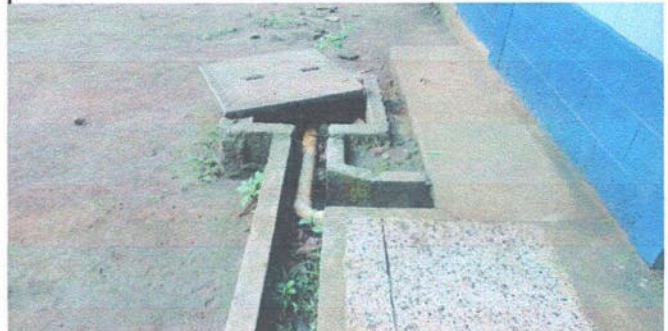
No.2 Sustitución de tubería PVC línea principal aguas negras 4"
