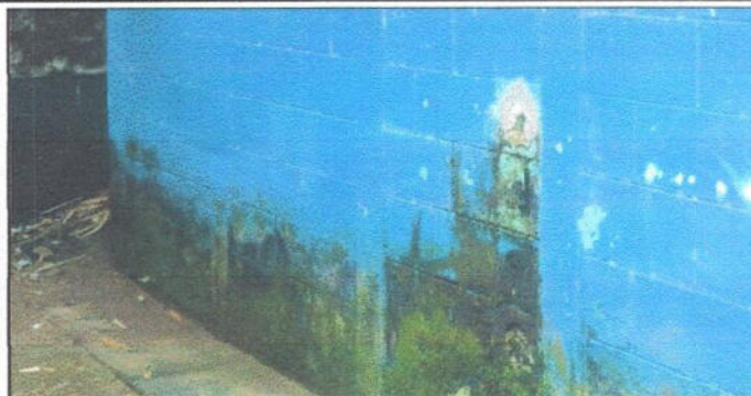
No.7 Reparación de Muro con Block 50 Kg/cm 2 14x19x39cm
