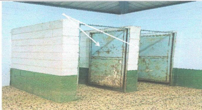
No.8 Sustitución de puerta de servicios sanitarios metalica
