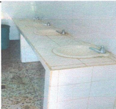
No.5 Sustitución lavamanos con grifería marca Prepon LL C/pedestal. S/loza color blanco para preprimaria
