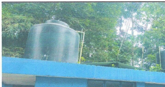
No.9 Sustitución de depósitos de agua 450 lts
