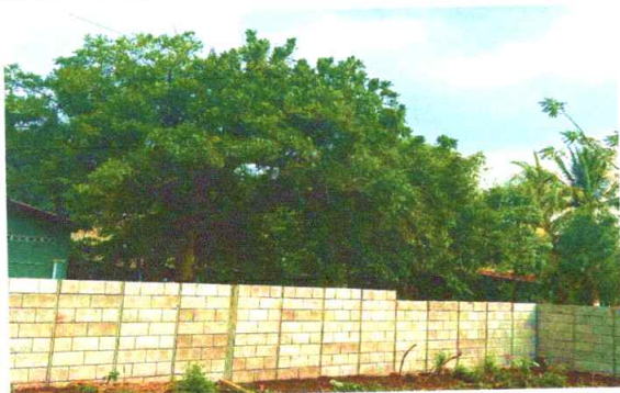
Foto 3: Acabado final del muro perimetral
