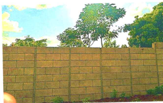
Foto 4: Acabado final del muro perimetral
