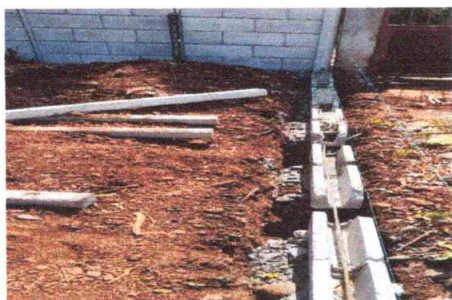
avance en la fundición de la base principal y fundición de muros sujetadores del muro perimetral,
