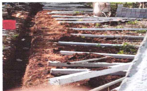
Foto 2: inicio del trabajo, sanjeado lineal para la fundición de bases de cemento.
