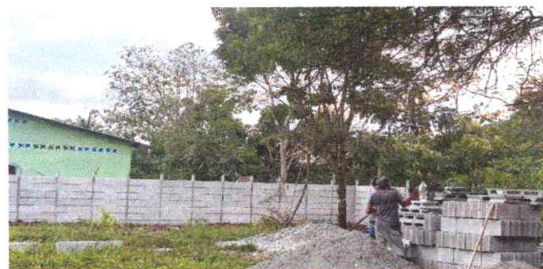
Foto 3: Avance en la segunda y tercera fase del muro perimetral
