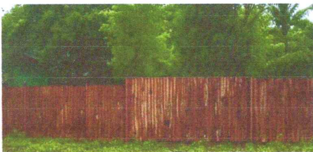
Foto 3: Sustrución de muro perimetral con barda prefabricada de concreto h=2m (concreto reforzado) 198m2
