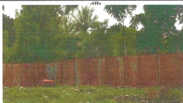
Foto 2: Sustrución de muro perimetral con barda prefabricada de concreto h=2m (concreto reforzado) 198m2
