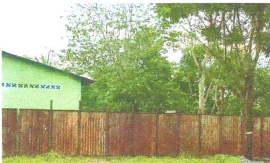
Foto 1: Sustrución de muro perimetral con barda prefabricada de concreto h=2m (concreto reforzado) 198m2
