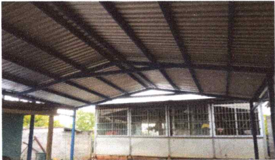
Foto 1: Sustitución de estructura de soporte de metal por metal - M² - 120 M²
