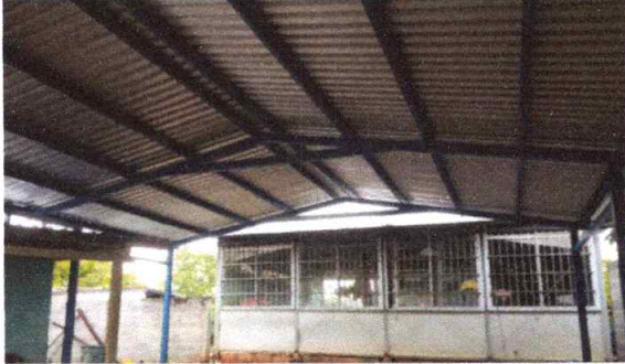
Foto 2: Sustitución de lámina, por lámina troquelada calibre 26 - M² - 120 M²
