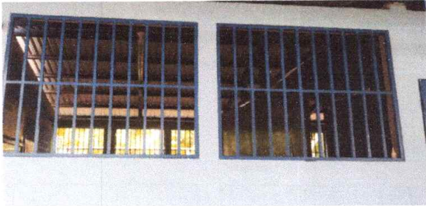
Foto 5: Sustitución de balcones - M² - 34 M²
