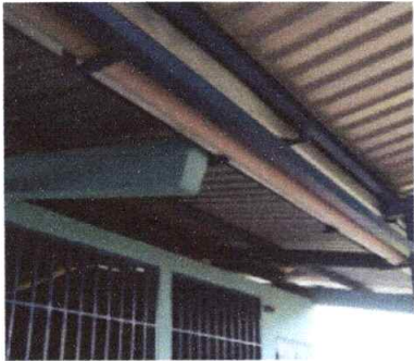
Foto 3: Sustitución de canal de metal - ML - 30 ML
