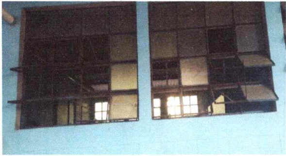
Foto 5: Sustrucción de balcones - M² - 34 M²
