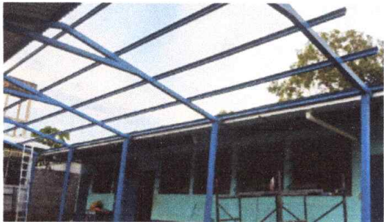
Foto 1: Sustrucción de estructura de soporte de metal por metal - M² - 120 M²
