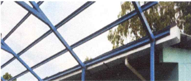
Foto 3: Sustrucción de canal de metal - ML - 30 ML
