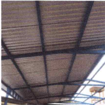
Foto 2: Sustrucción de lámina, por lámina troquelada calibre 26 - M² - 120 M²
