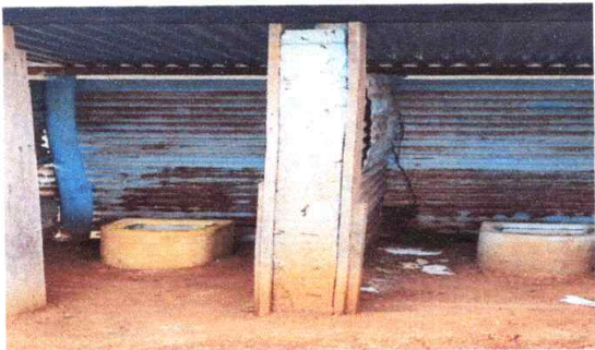
Foto 7: Sustitución de inodoro elongado
