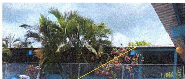
Foto 10: Sustrucción de canatela por canaleta metálica.
