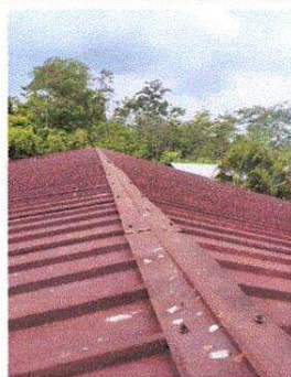
Foto 9: Sustrucción de capote metálico
