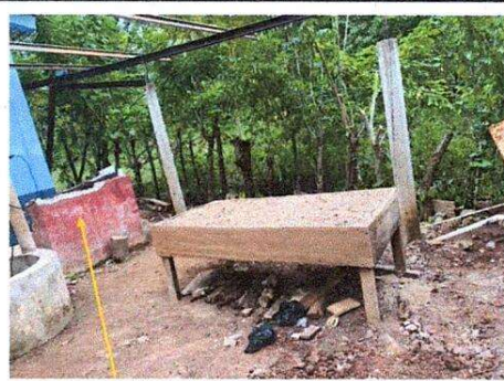
Foto 8: Instalación de pila
