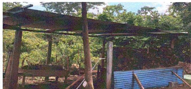
SUSTITUCIÓN DE ESTRUCTURA DE SOPORTE MADERA POR METAL
