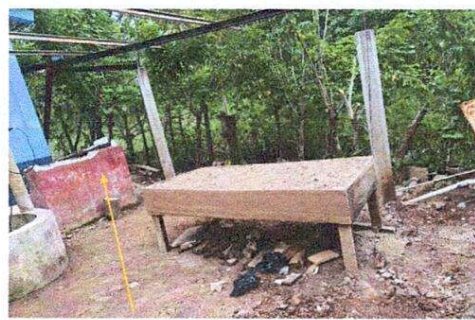
SUSTITUCIÓN DE PILA PLÁSTICA DE DOS LAVADEROS
