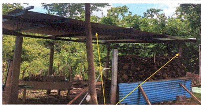
Foto 7: Sustrucción de estructura de madera por metal
