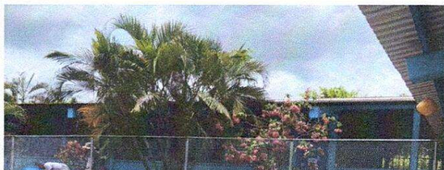
SUSTITUCIÓN CANAL DE METAL
