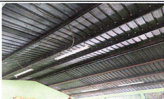
Foto 11: Reparación de cableado eléctrico.
