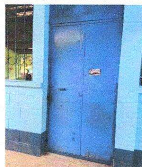
MANTENIMIENTO A ESTRUCTURA DE PUERTA (APLICACION DE PINTURA)
