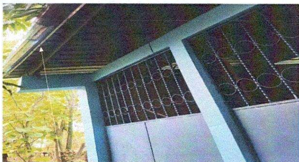
SUSTITUCION DE BAJADA DE AGUA PLUVIAL METAL POR TUBO PVC 3"
