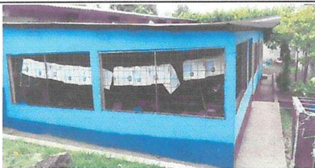
Sustitución de balcones de metal
