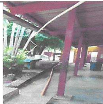
Sustitución de columnas de metal por tubo cuadrado de metal de 4"
