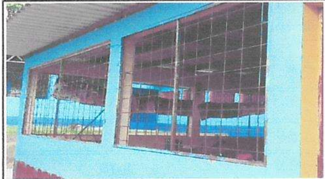
Sustitución de balcones de metal
