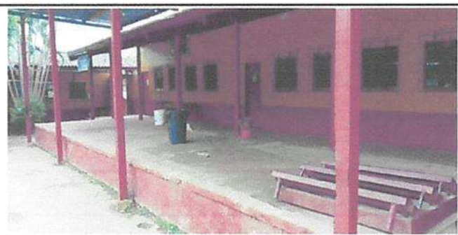
Sustitución de columnas de metal por tubo cuadrado de metal de 4"
