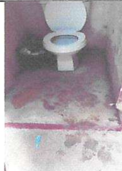
Sustitución de piso cerámico
