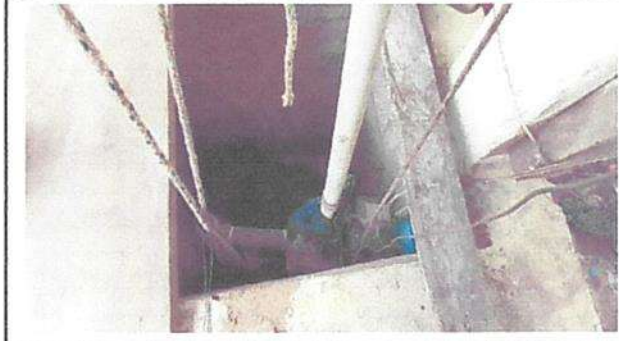
Mantenimiento de pozo artesanal (incluye: lavado, sustitución de bomba de agua, sustitución de tubería e instalación de cableado eléctrico)
