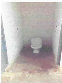
Sustitución de azulejo
