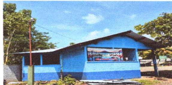
Sustitución 800 metros de lámina por lámina troquelada calibre 26 Aluzinc
