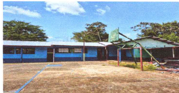
Sustitución 800 metros de lámina por lámina troquelada calibre 26 Aluzinc
