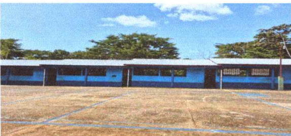
Sustitución 800 metros de lámina por lámina troquelada calibre 26 Aluzinc
