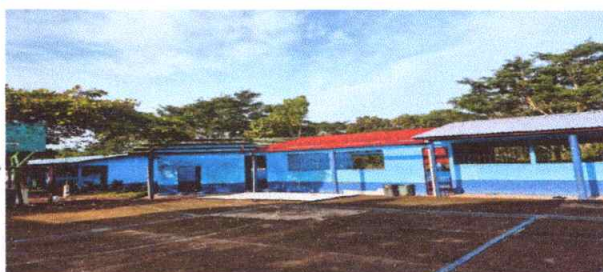
Sustitución 800 metros de lámina por lámina troquelada calibre 26 Aluzinc
