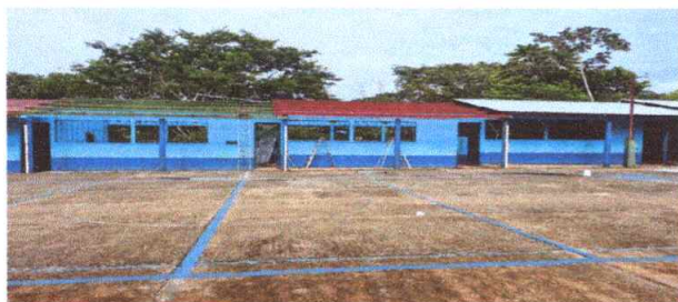
Sustitución 800 metros de lámina por lámina troquelada calibre 26 Aluzinc
