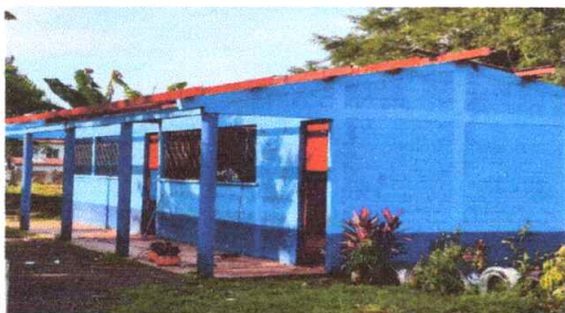
Sustitución 800 metros de lámina por lámina troquelada calibre 26 Aluzinc
