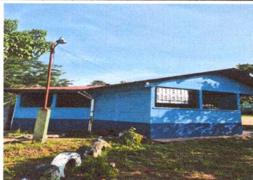
Sustitución de lámina por lámina troquelada calibre 26 Aluzinc
