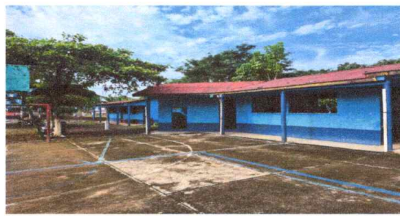
Sustitución de lámina por lámina troquelada calibre 26 Aluzinc
