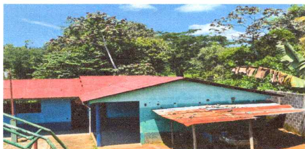
Sustitución de lámina por lámina troquelada calibre 26 Aluzinc
