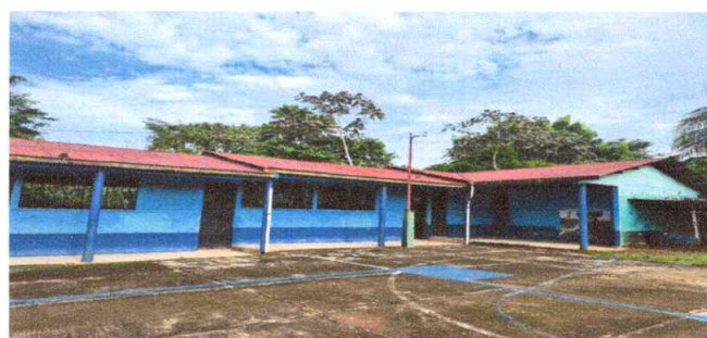
Sustitución de lámina por lámina troquelada calibre 26 Aluzinc
