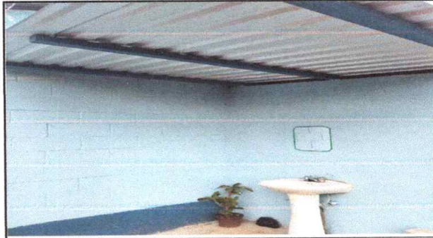
Foto 8: Sustrucción de cubierta de lámina en baños
