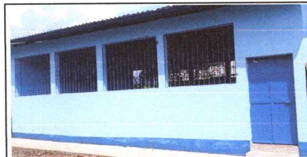
Foto 10: Mantenimiento a estructura cepillado, lijado y aplicación de pintura de puertas y balcones
