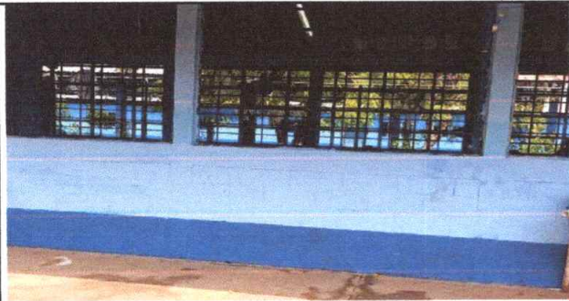
Foto 13: Suministro y Aplicación de pintura exterior latex azul para zocalo 4 hiladas
