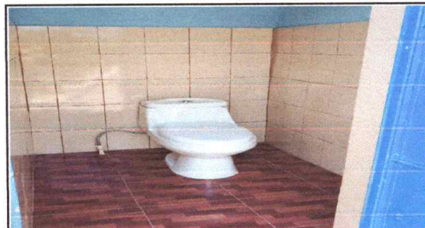
Foto 4: Sustrucción de servicios sanitarios y sus accesorios
