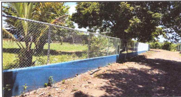
Foto 7: Sustrucción de tubo hg y malla galvanizada
