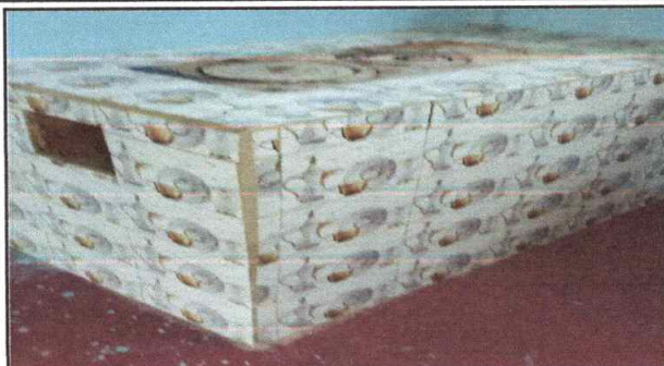
Foto 2: Sustrucción de estufa rural completa incluye, chimenea, plancha de metal, azulejo y ladrillo.
