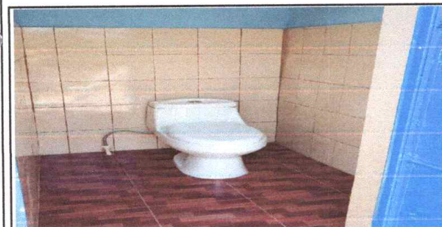
Foto 5: Sustrucción de azulejo en baños
