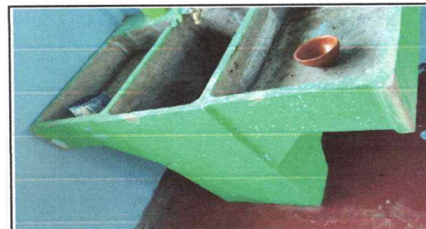
Foto 6: Sustrucción de pila de cemento prefabricado de dos lavaderos
