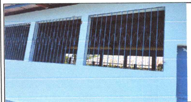
Foto 11: Mantenimiento de Balcones
