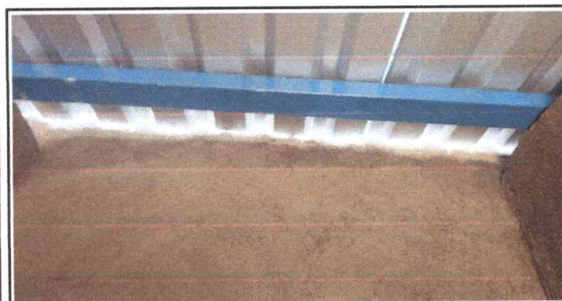
Foto 9: Sustrucción de estructura de soporte de madera, por metal en baños
