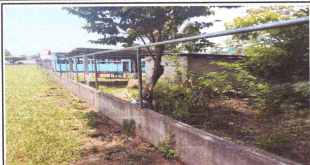
Foto 7: Sustrucción de tubo hg y malla galvanizada
