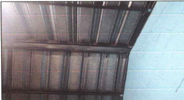
Foto 14: Sustitución de capote de lámina para lamina troquelada
