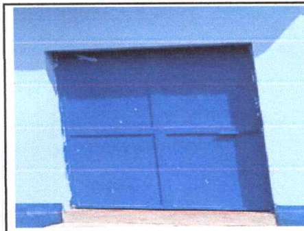
Foto 10: Mantenimiento a estructura cepillado, lijado y aplicación de pintura de puertas y balcones
