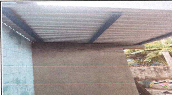
Foto 8: Sustrucción de cubierta de lámina en baños
