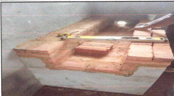
Foto 2: Sustitución de estufa rural completa incluye, chimenea, plancha de metal, azulejo y ladrillo.
