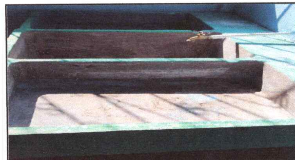
Foto 6: Sustitución de pila de cemento prefabricado de dos lavaderos
