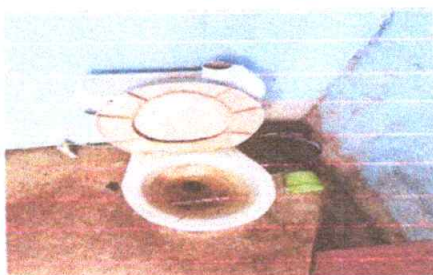
Sustitución de azulejo
