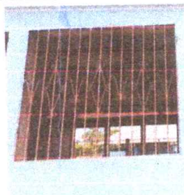
Mantenimiento de balcones
