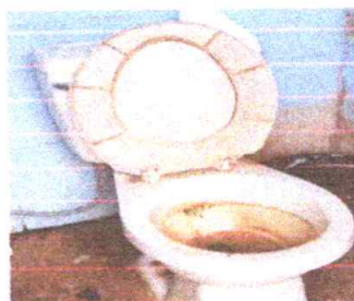
Sustitución de inodoro elongado
