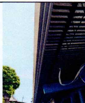
Foto 6: Sustrucción de 36 metros lineales de canal de metal por aluminio
