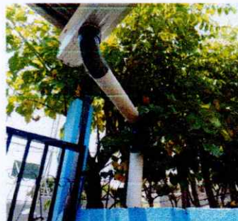
Foto 8: Sustrucción de bajada de agua pluvial por tubo PVC blanco 80 grados de presión
