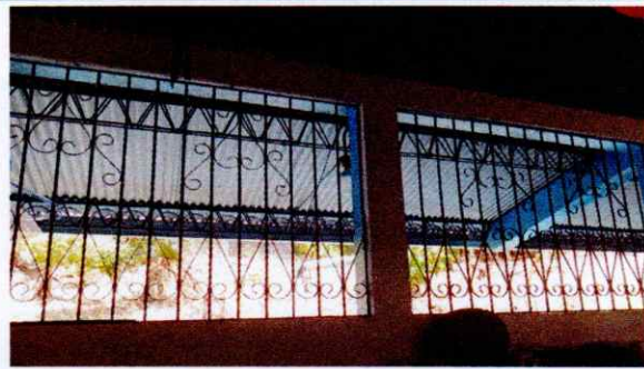
Foto 2: Sustrucción de 42 metros cuadrados de estructura de metal de ventana
