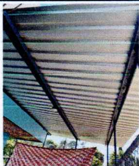
Foto 7 : Sustrucción de 40 metros cuadrados de lamina por lamina troquelada calibre 26
