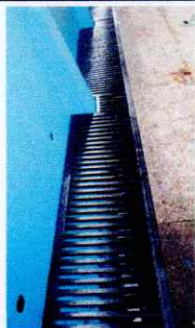
Foto 3: Sustrucción de 32 metros lineales de rejilla metálica
