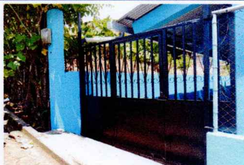
Foto 4: Sustrucción de portón metálico de 2.75 metros de ancho por 2.15 metros de alto
