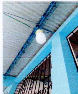
Foto 10: Sustrucción de lámparas existentes con lámparas bombillo LED GLOBO 30 W para pasillos 2400 lúmenes
