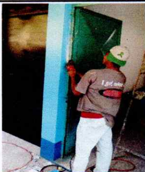
Foto 1: Sustitución de nueve puertas metálicas de 1 metro de ancho por 3.6 metros de alto.
