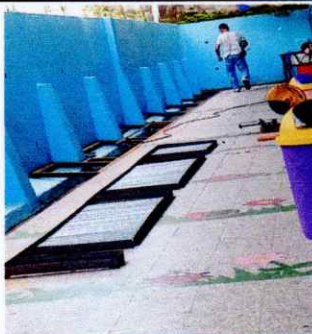
Foto 3: Sustitución de 32 metros lineales de rejilla metálica
