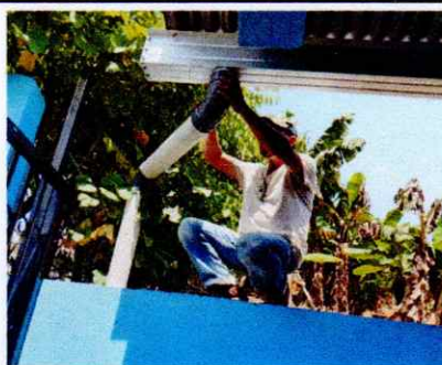
Foto 8: Sustitución de bajada de agua pluvial por tubo PVC blanco 80 grados de presión
