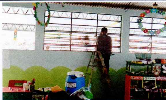
Foto 2: Sustitución de 42 metros cuadrados de estructura de metal de ventana
