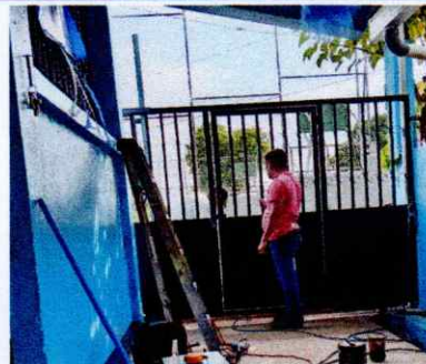
Foto 4: Sustitución de portón metálico de 2.75 metros de ancho por 2.15 metros de alto
