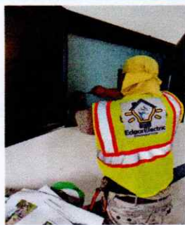
Foto 5: Reparación y mantenimiento de sistema eléctrico
