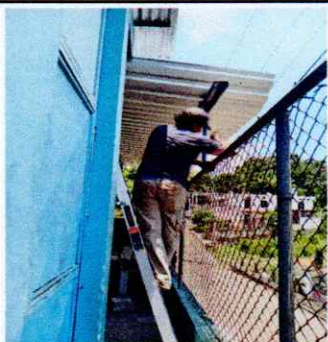
Foto 7 : Sustitución de 40 metros cuadrados de lamina por lamina troquelada calibre 26
