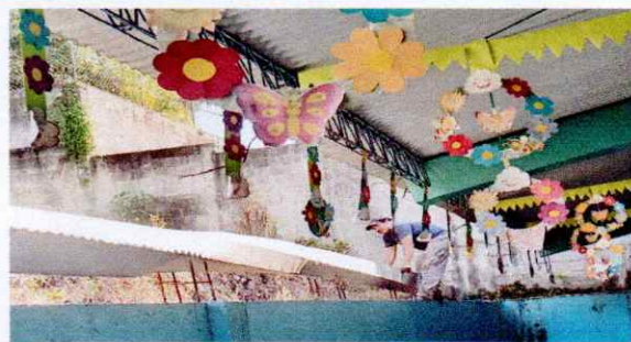
Foto 6: Sustitución de 36 metros lineales de canal de metal por aluminio
