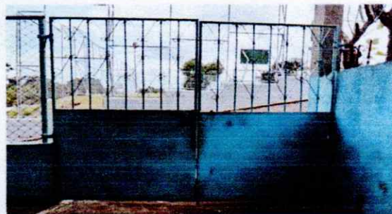
Foto 4: Sustrucción de portón metálico
