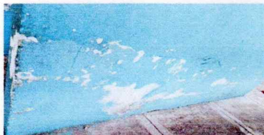
Foto 9: Pintura en muros exteriores e interiores
