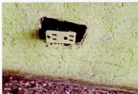
Foto 5: Reparacion y mantenimiento de sistema electrico
