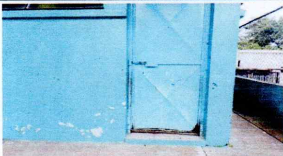
Foto 1: Sustrucción de puertas metálicas
