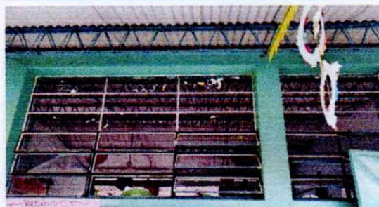
Foto 2: Sustrucción de estructura de metal de ventana
