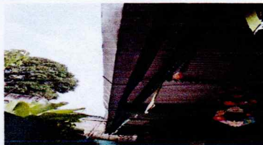
Foto 6: Sustrucción de canal de metal por aluminio
