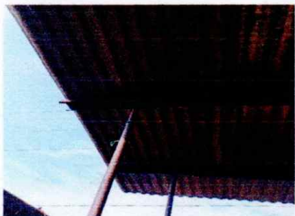
Foto 7 : Sustitución de lamina por lamina troquelada calibre 26
