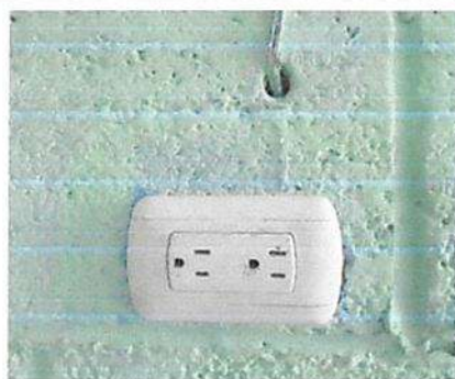
Sustitución de tomacorrientes dobles
