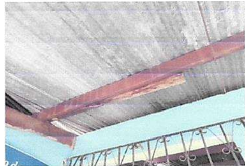
Mantenimiento a estructura de soporte de metal
