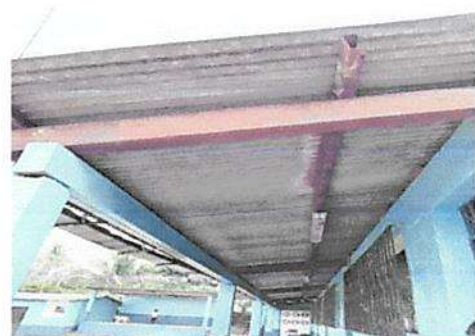
Mantenimiento a estructura de soporte de metal
