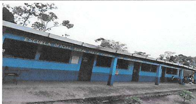
Sustitución de canal de metal
