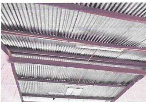
Mantenimiento a estructura de soporte de metal
