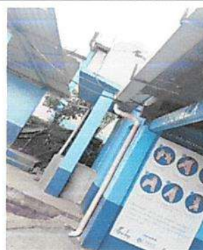
Sustitución de bajada de agua pluvial de metal por tubo PVC 4"
