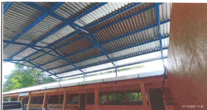
Foto 3: Sustitución de canal de metal 13 ML
