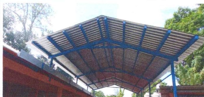
foto 1: Sustrucción de lamina por lamina troquelada 130 mts2
