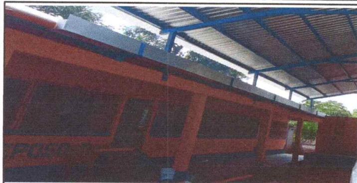
Foto 1: Sustitución de canal de metal 13 ML
