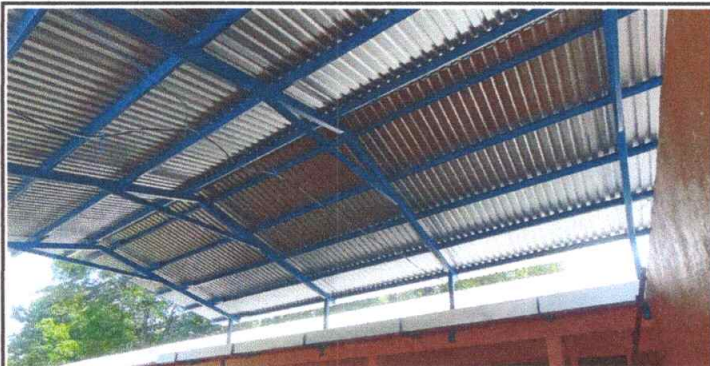
foto 3: Sustrucción de lamina por lamina troquelada 130 mts2
