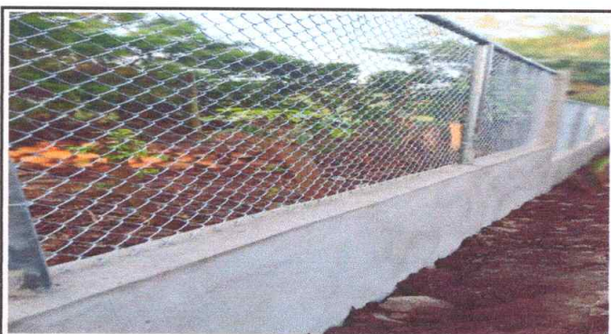
Foto3: Reparación de muro perimetral existente de block con tubo hg y malla galvanizada 110 M2
