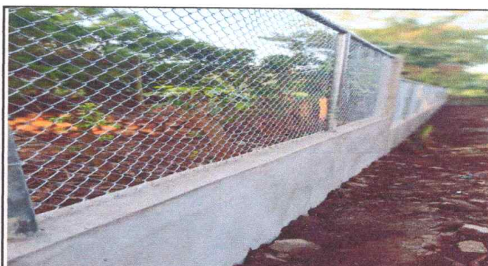
Foto1: Reparación de muro perimetral existente de block con tubo hg y malla galvanizada 110 M2
