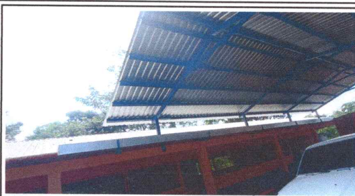
Foto 2: Sustitución de canal de metal 13 ML
