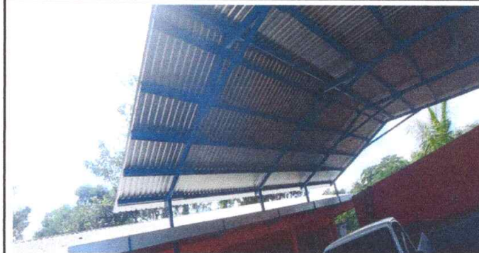
foto 2: Sustrucción de lamina por lamina troquelada 130 mts2
