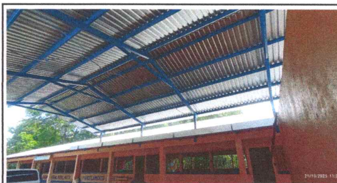
Foto 3: Sustrucción de estructura de soporte de metal por metal 130mts2
