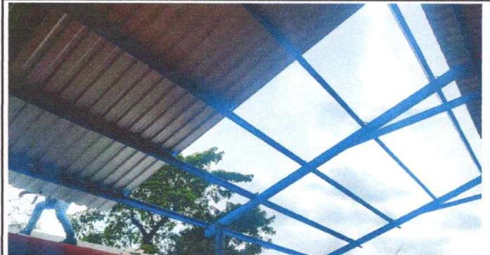
foto 2: Sustrucción de lamina por lamina troquelada 130 mts2
