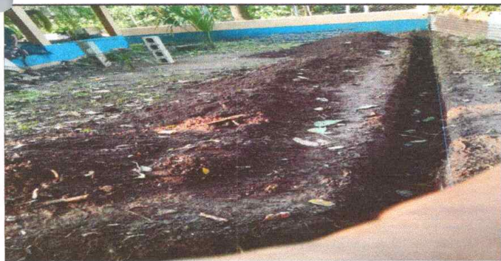
Foto2: Reparación de muro perimetral existente de block con tubo hg y malla galvanizada 110 M2
