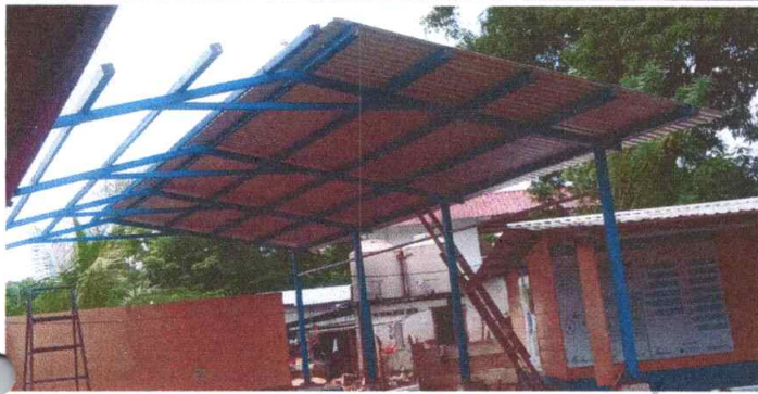
foto 1: Sustrucción de lamina por lamina troquelada 130 mts2
