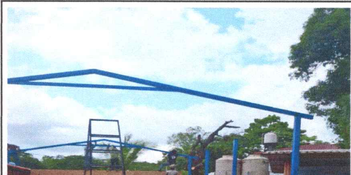
Foto 1: Sustrucción de estructura de soporte de metal por metal 130mts2
