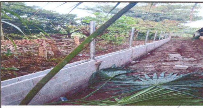
Foto3: Reparación de muro perimetral existente de block con tubo hg y malla galvanizada 110 M2
