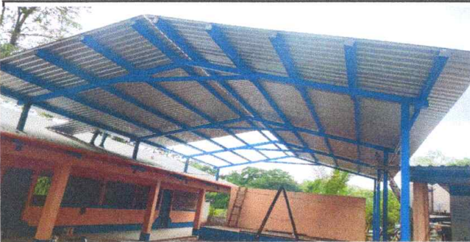
foto 3: Sustrucción de lamina por lamina troquelada 130 mts2
