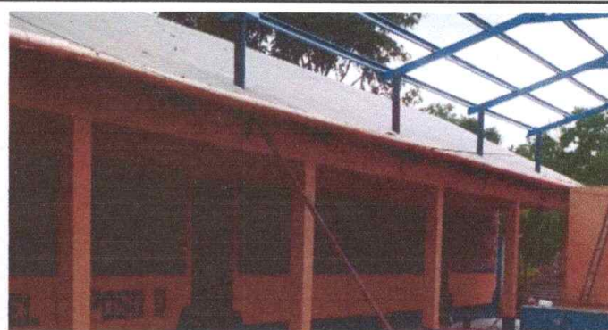
Foto 2: Sustitución de canal de metal 13 ML
