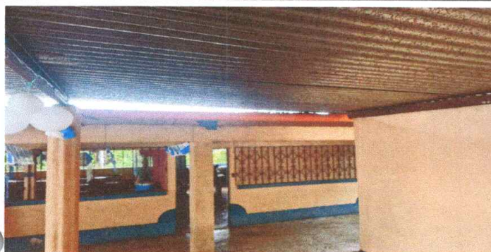
Foto 1: Sustitución de canal de metal 13 ML
