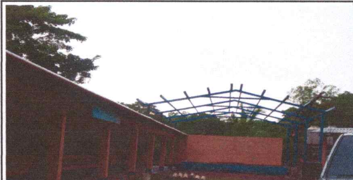
Foto 2: Sustrucción de estructura de soporte de metal por metal 130mts2
