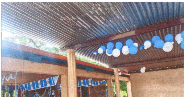
Foto 3: Sustitución de canal de metal 13 ML
