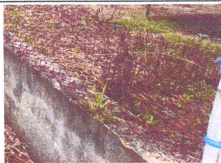
Foto 6: Reparación de muro perimetral existente de block con tubo hg y malla galvanizada 110m2
