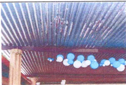
Foto 5: Sustitución de lámina, por lámina troquelada calibre 26 130m2
