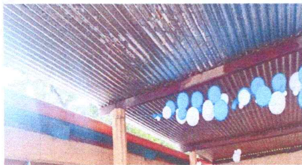
Foto 1: Sustitución de lámina, por lámina troquelada calibre 26 130m2
