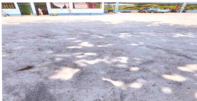
foto 1: Sustrucion de piso de torta de concreto 400 metros cuadrados
