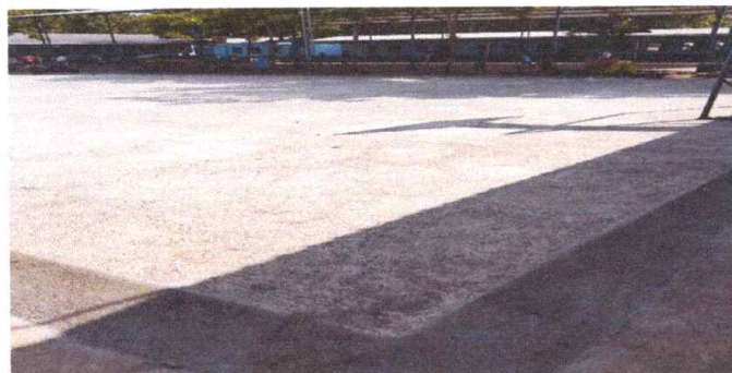
Foto 5: Sustrucion de piso de torta de concreto 400 metros cuadrados
