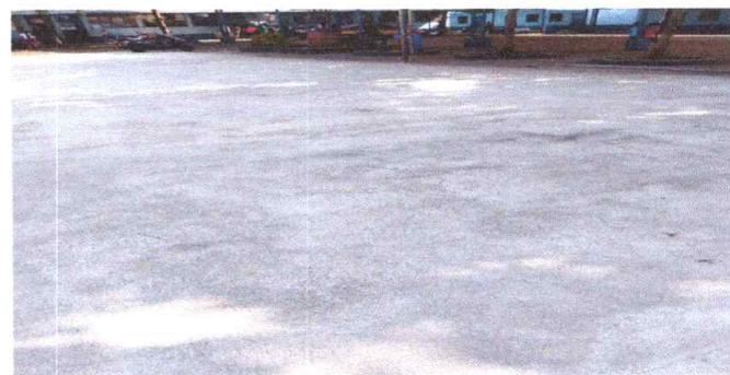
foto 2: Sustrucion de piso de torta de concreto 400 metros cuadrados
