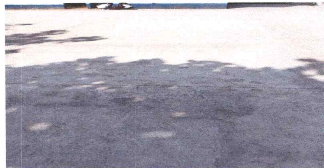
Foto 4: Sustrucion de piso de torta de concreto 400 metros cuadrados
