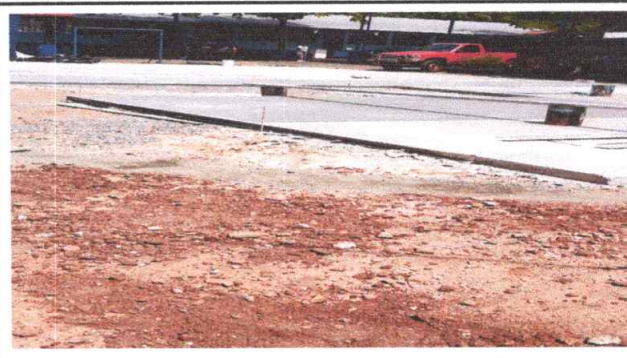
Foto 2: Sustrucion de piso de torta de concreto 400 metros cuadrados
