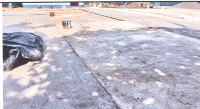
Foto 1: Sustrucion de piso de torta de concreto 400 metros cuadrados
