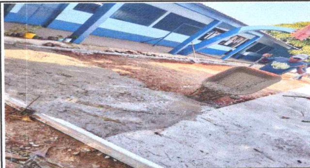
Foto 6: Sustrucion de piso de torta de concreto 400 metros cuadrados
