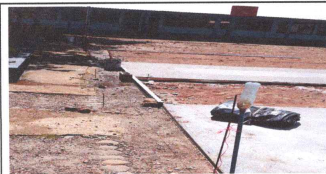
Foto 3: Sustrucion de piso de torta de concreto 400 metros cuadrados
