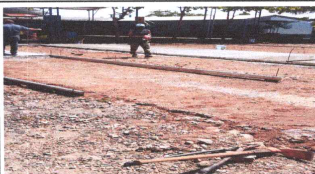
Foto 4: Sustrucion de piso de torta de concreto 400 metros cuadrados
