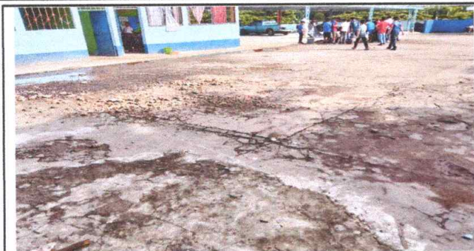
400 metros cuadrados de sustitucion de piso de torta de concreto
