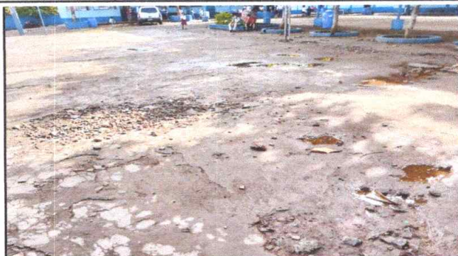
400 metros cuadrados de sustitucion de piso de torta de concreto
