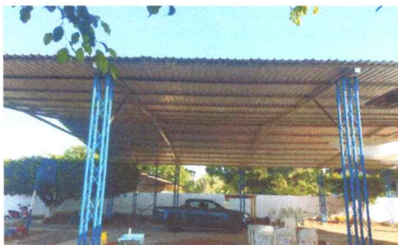
foto 3: Sustitución de estructura de soporte de metal por metal 400 M2
