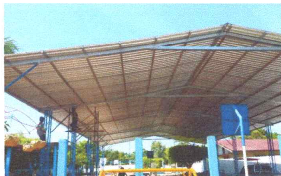
foto 2: Sustitución de estructura de soporte de metal por metal 400 M2
