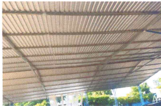
Foto 4: Sustitución de lamina por lamina troquelada 400 M2
