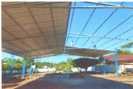
foto 1: Sustitución de estructura de soporte de metal por metal 400 M2
