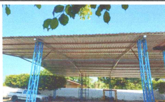
Foto 6: Sustitución de lamina por lamina troquelada 400 M2
