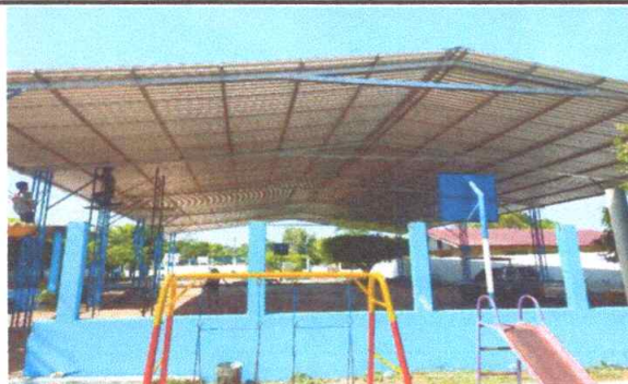
Foto 5: Sustitución de lamina por lamina troquelada 400 M2
