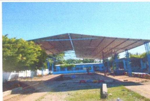
Foto 6: Sustrución de lamina por lamina troquelada 400 M2
