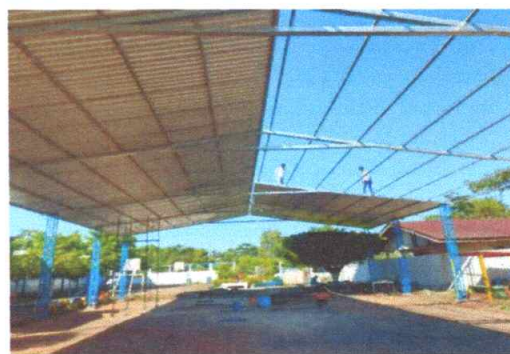
Foto 4: Sustrución de lamina por lamina troquelada 400 M2
