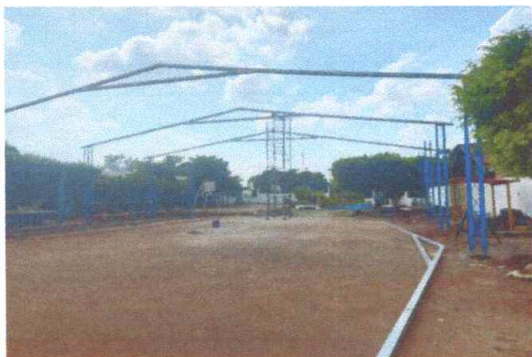
foto 1: Sustrución de estructura de soporte de metal por metal 400 M2
