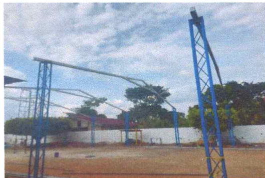
foto 2: Sustrución de estructura de soporte de metal por metal 400 M2
