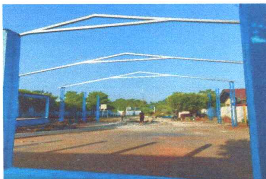
foto 3: Sustrución de estructura de soporte de metal por metal 400 M2
