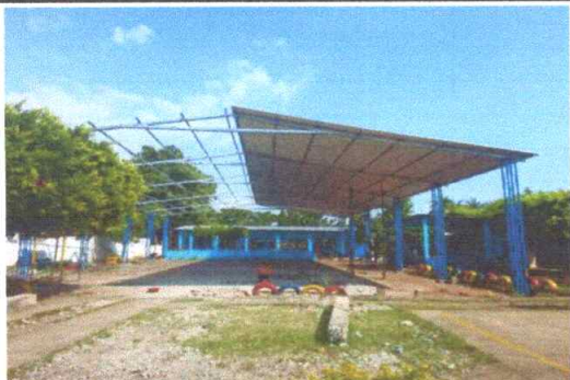
Foto 5: Sustrución de lamina por lamina troquelada 400 M2
