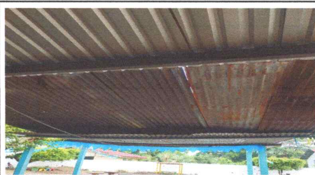
Sustitución de lámina, por lámina troquelada calibre 26
