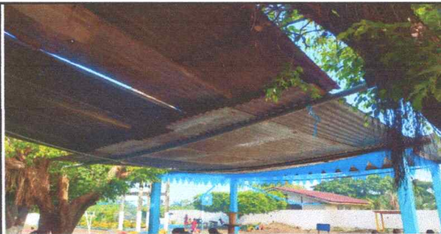
Sustitución de lámina, por lámina troquelada calibre 26
