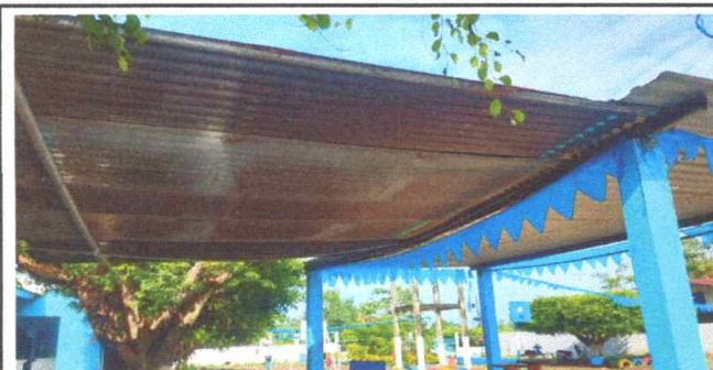
Sustitución de lámina, por lámina troquelada calibre 26
