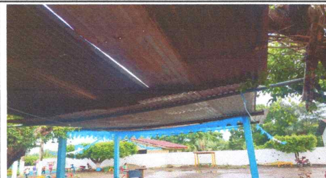
Sustitución de lámina, por lámina troquelada calibre 26
