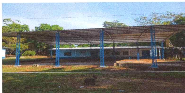
foto 1 sustrucción de lamina por lamina troquelada calibre 26
