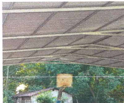
foto 2 sustrucción de lamina por lamina troquelada calibre 26
