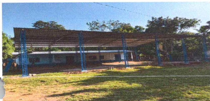
foto 3 sustrucción de estructura de soporte metal por metal
