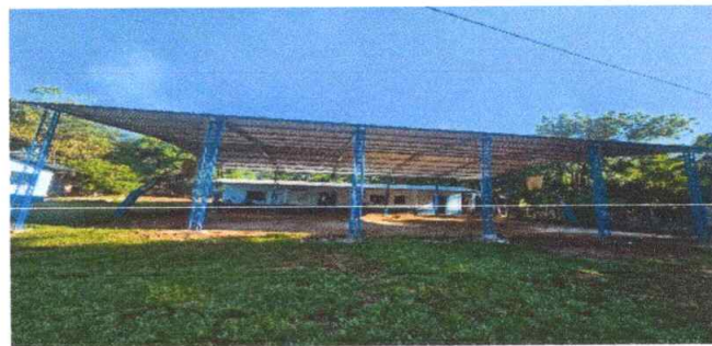
foto 6 mantenimiento de cancha en columnas metalicas tipo joist
